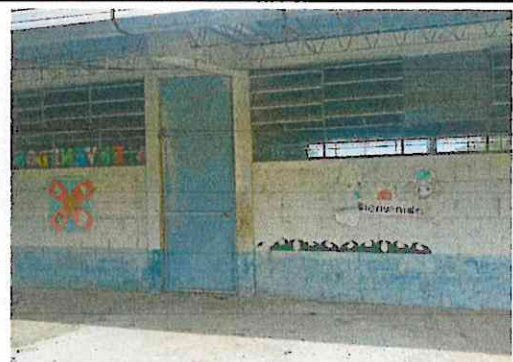
Foto 4: Mantenimiento de puerta de metal y chapas
