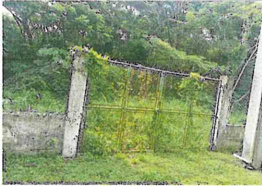
Foto 7: Mantenimiento a portón
