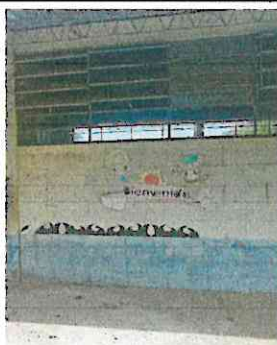
Foto 5: Mantenimiento de ventana de metal
