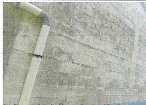
Foto 8: Reparación de muro perimetral
