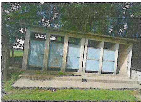
Foto 3: Mantenimiento de puertas de metal
