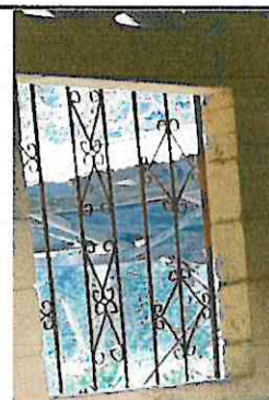
Foto 6: Mantenimiento de balcones
